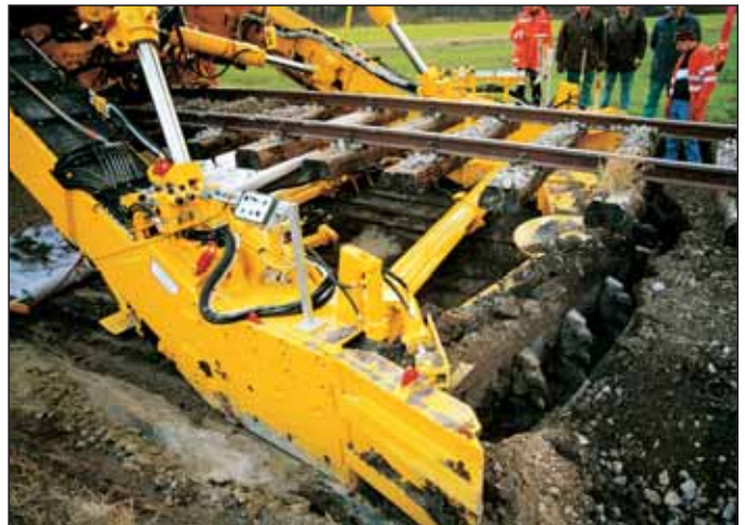
Abb. 6: Aushubkette einer Unterbauanierungsmaschine
