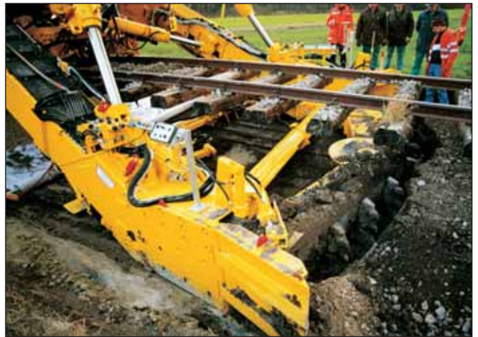
Abb. 6: Aushubkette einer Unterbauanierungsmaschine
